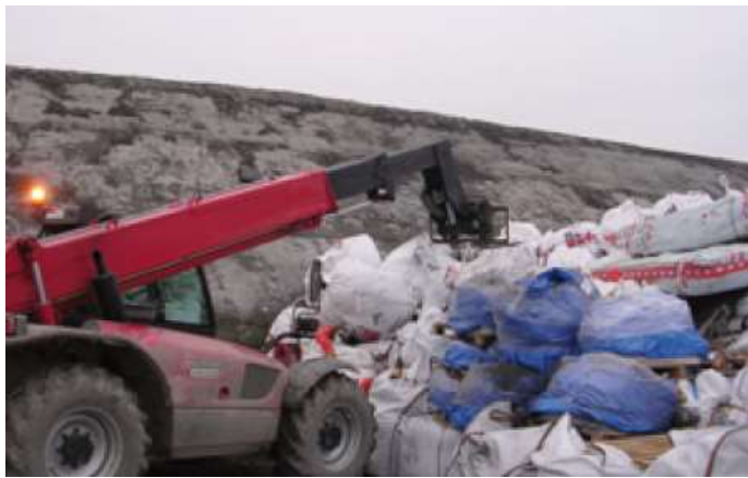
Figure 21 : Mise en œuvre des big bags
