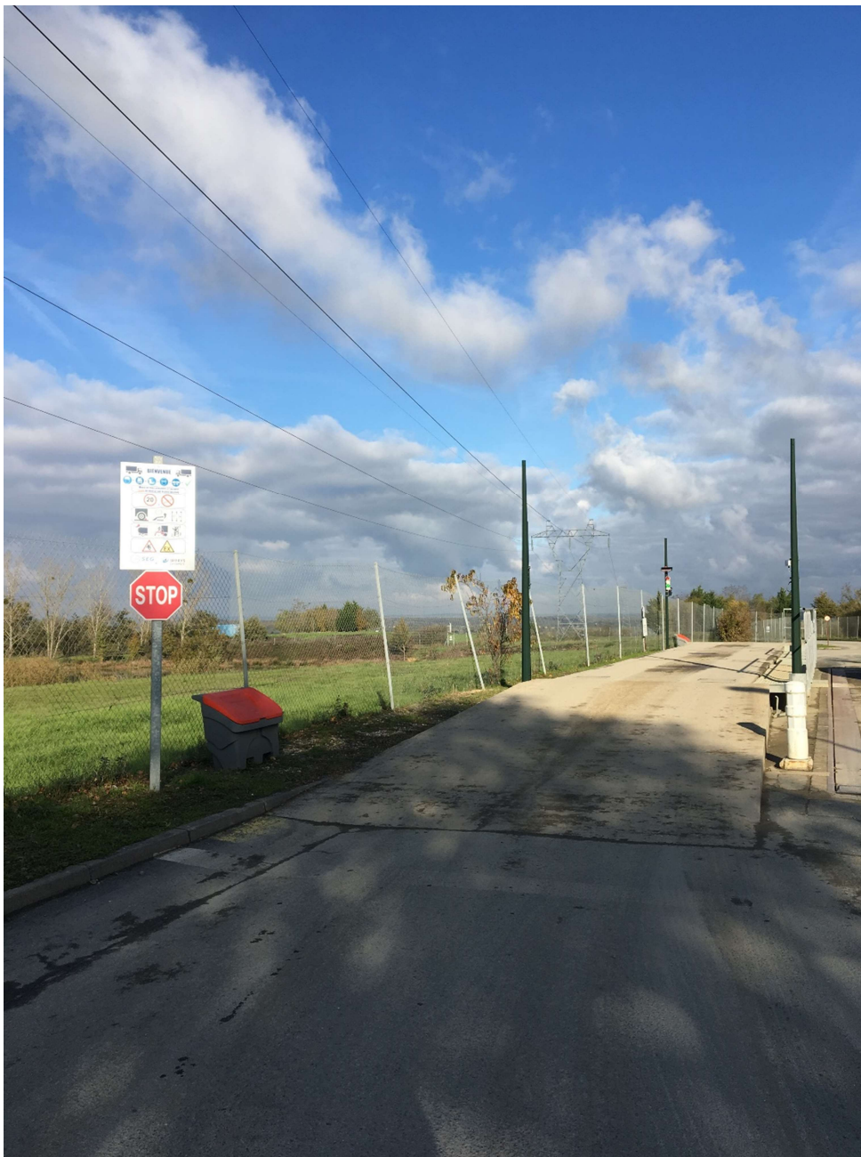
Figure 6 : Pont bascule (entrée commune ISDND de Gournay et carrière)
