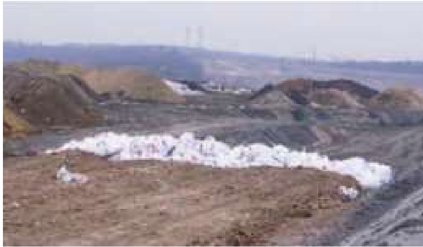
Figure 22 : Opération de régalinge des déchets stockés
